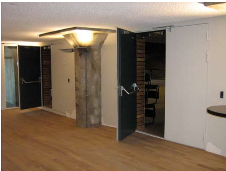
Porte de secours Pakhuis Willem de Zwijger Amsterdam (NL)
